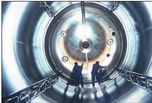
Електрополиране на място
